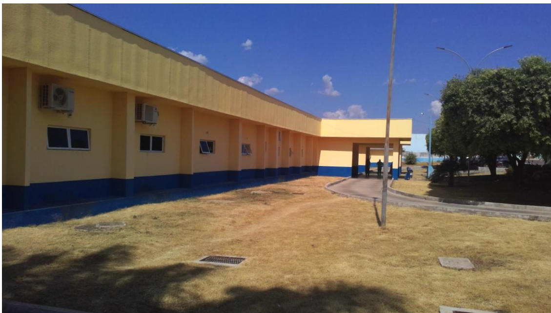
Figura 5 - Hospital Regional de Peixoto De Azevedo
