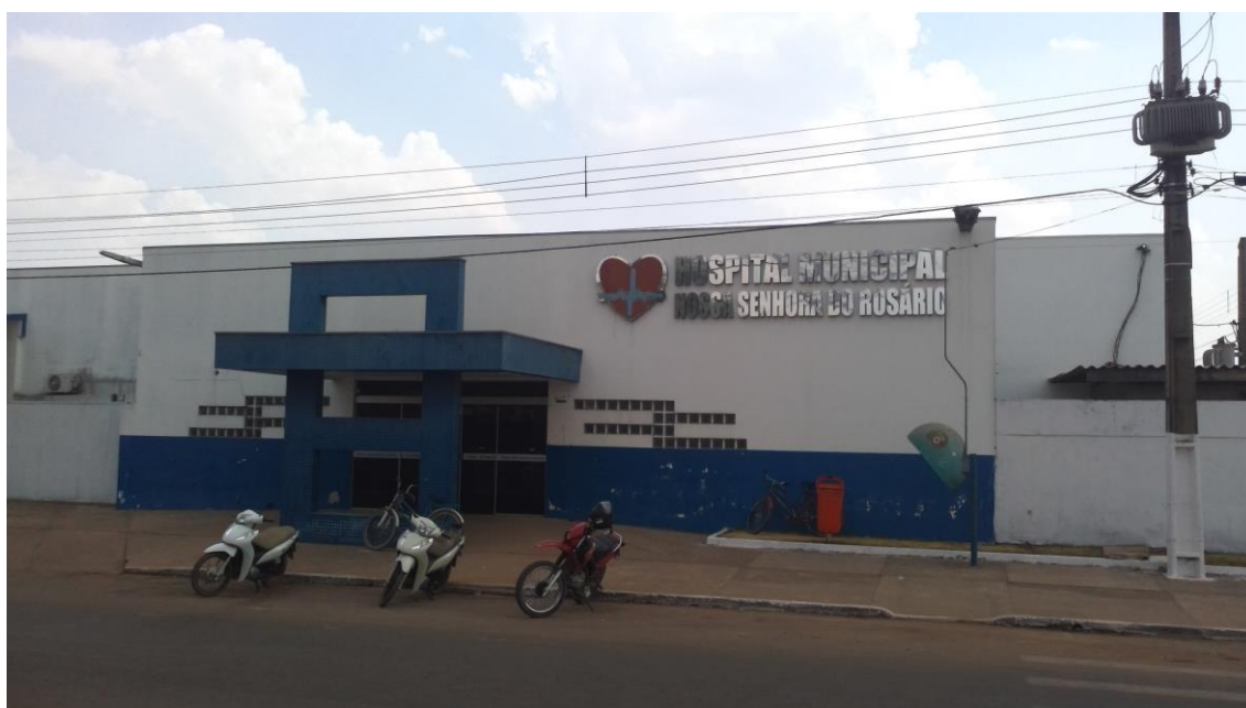
Figura 4 - Hospital Municipal Nossa Senhora do Rosário (Guarantã do Norte)
